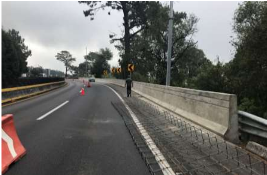
Autopista México-Cuernavaca (Muro Lateral)
